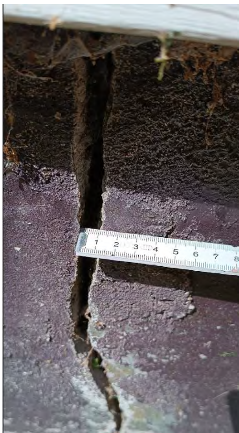
Rys. 5 Widoczne zarysowanie fundamentu i szczelina o szerokości 10mm
