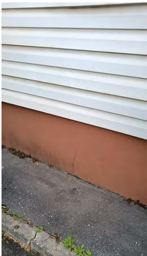
Rys. 3 Widoczne zarysowanie fundamentu
