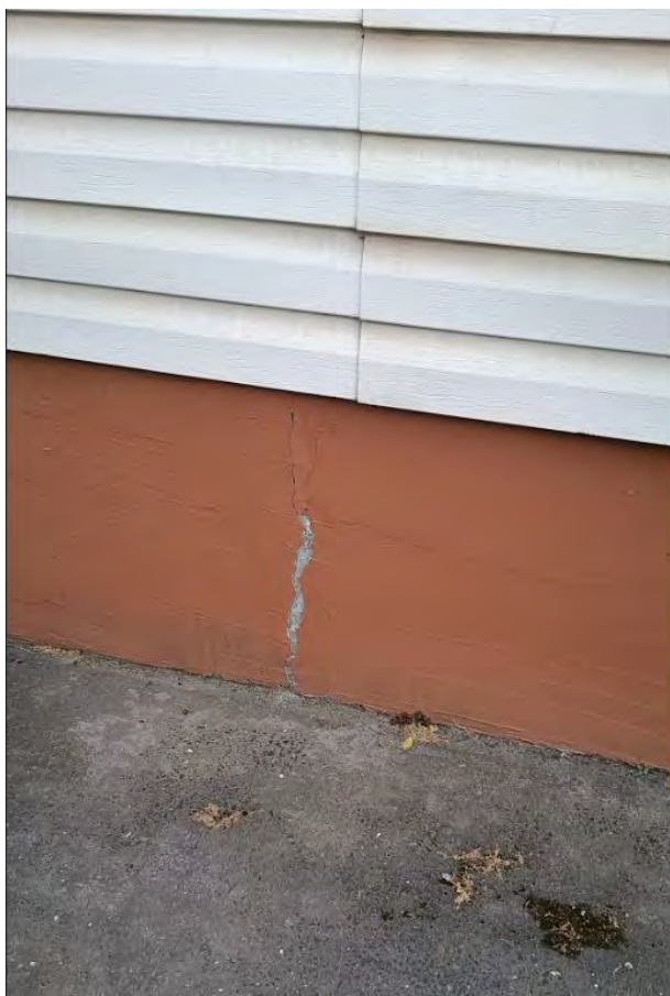
Rys. 4 Widoczne zarysowanie fundamentu
