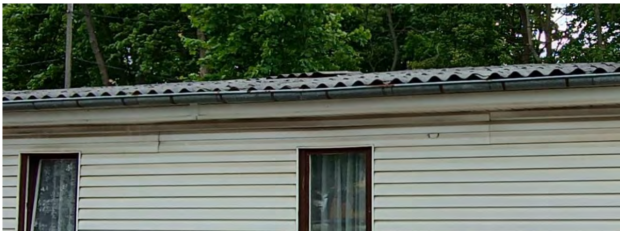
Rys. 6 Widoczna nieszczelność pokrycia dachowego
