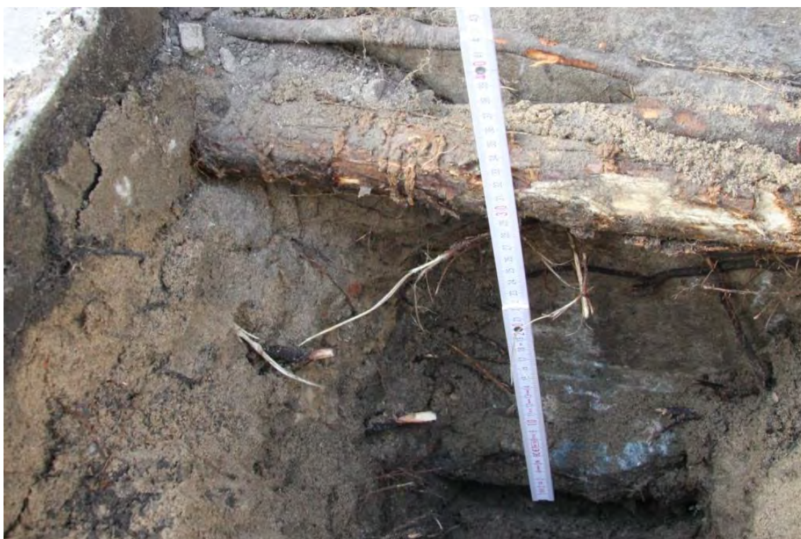
Rys. 8 Odkrywka fundamentu 1– głębokość posadowienia 35cm
