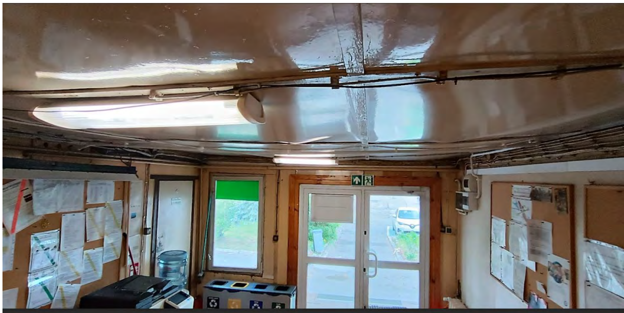
Rys. 7 Widoczne nadmierne ugięcie sufitu w korzytarzu wejściowym
