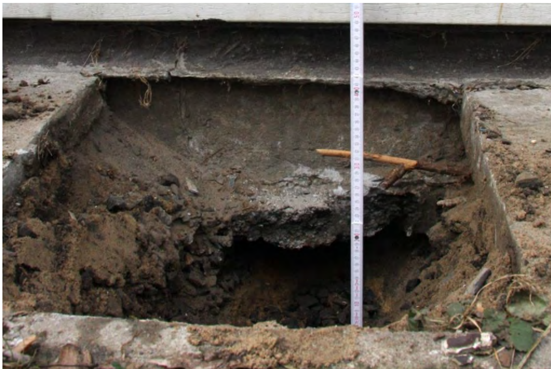
Rys. 9 Odkrywka fundamentu 2 – głębokość posadowienia 25cm
